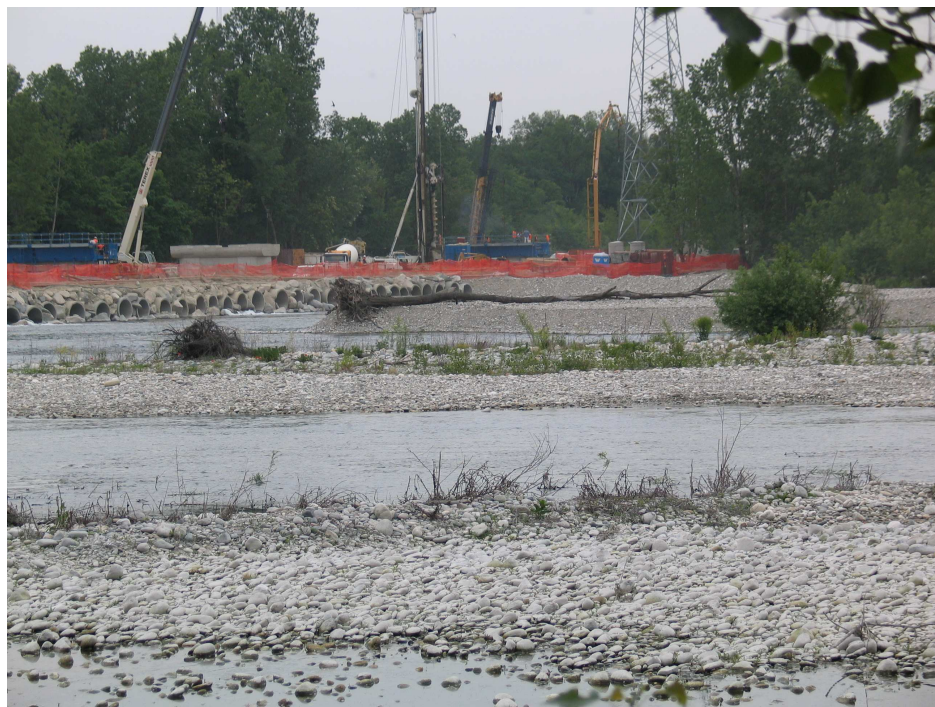
Fig. 15 - Lavori attraversamento TAV, Trecate.
