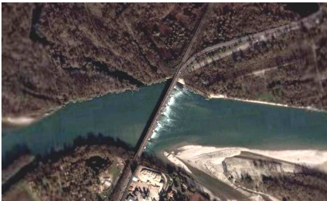
Fig. 14 - Ponte stradale e ferroviario, Vigevano.
